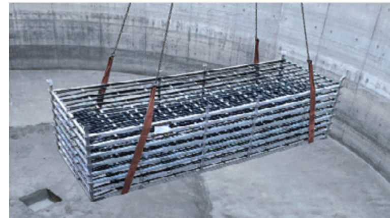
Messer-Belüftungsmatten - die einfache und wirksame Lösung für den Sauerstoffeintrag
